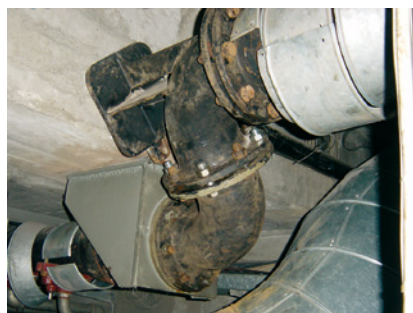
Vor der Reinigung: 25 bis 30 mm dicke Inkrustierungen.
