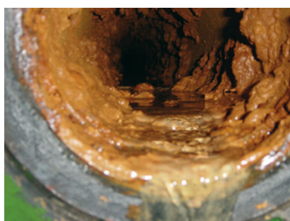
Vor der Reinigung: 25 bis 30 mm dicke Inkrustierungen.
